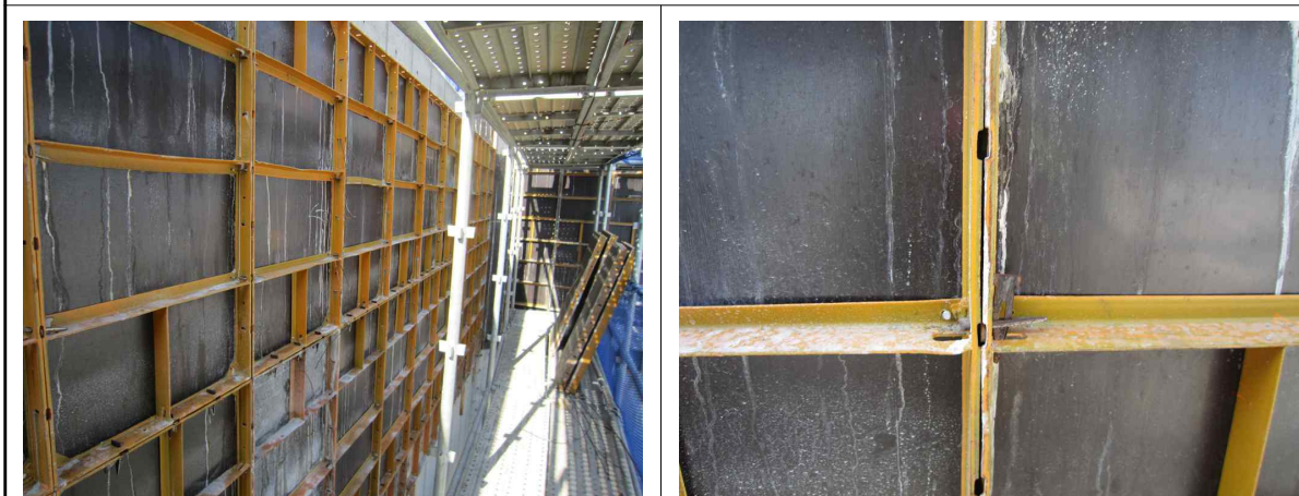
교량 A2 거푸집 설치 상태 현황
