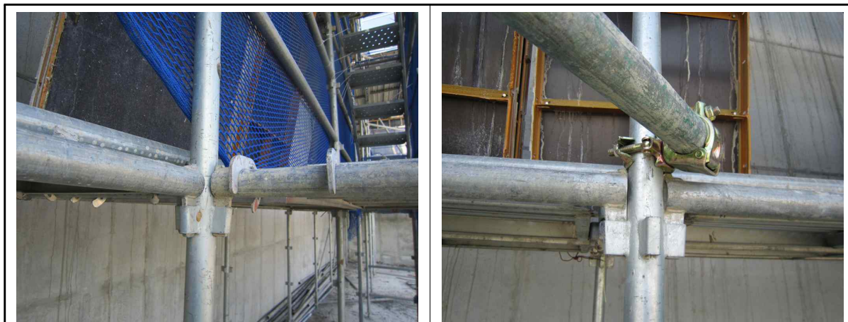
교량 A2 시스템동바리 수직재, 수평재 체결상태 현황
