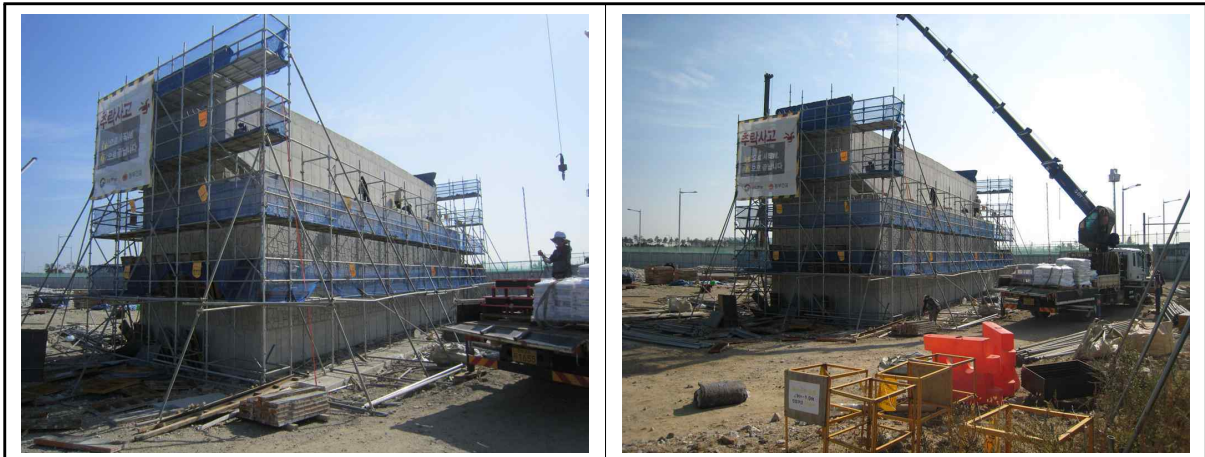
교량 A2 거푸집 설치
